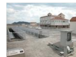
水處理系統 電氣儀表系統
