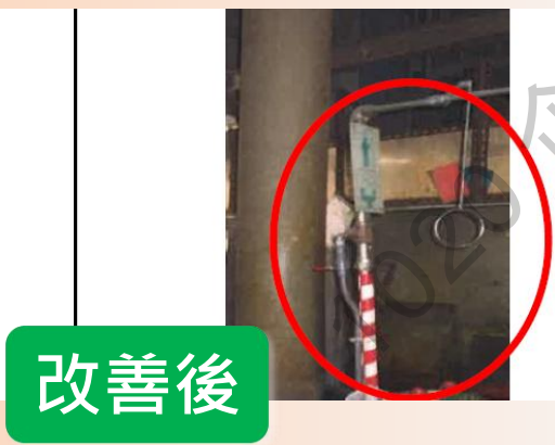
增設緊急淋浴設備
