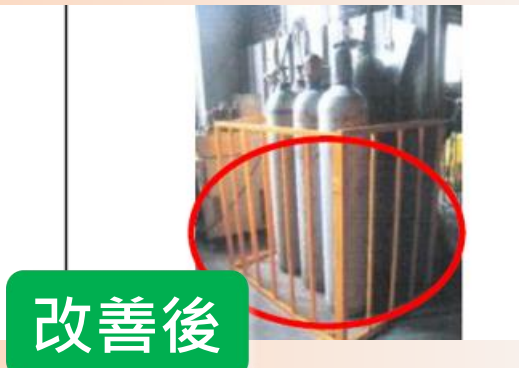
增設鋼瓶固定裝置
